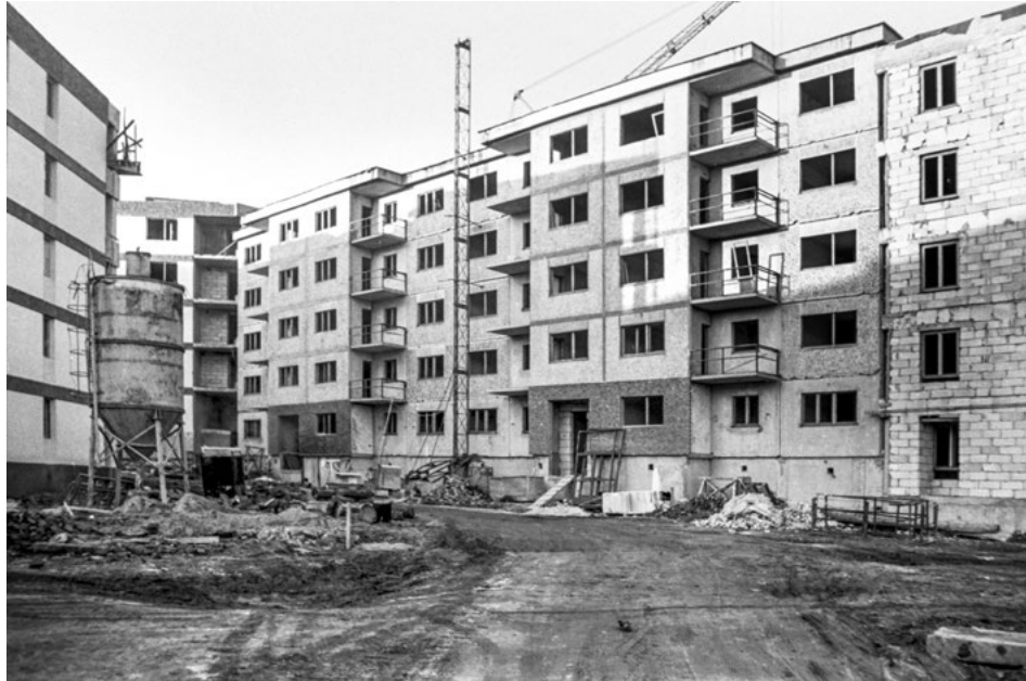
Épül a Bethlen negyed Construcția cartierului Beclean The Bethlen Quarter under construction • 1985
